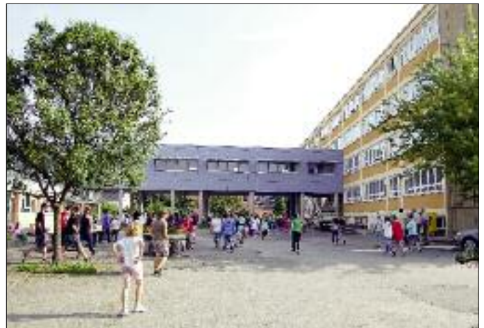
Auch das Förderschulzentrum bekam am gleichen Tag den neu errichteten Schulanbau durch den Oberbürgermeister und Vertretern der Stadtverwaltung übergeben.
